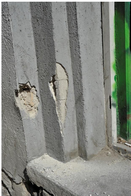
15. kép Vakolt keret a jobb oldali boltportál kávéján
