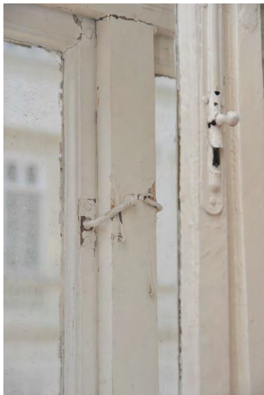
16. kép Ablakfélfordító a 102. sz. ablak külső rétegén
