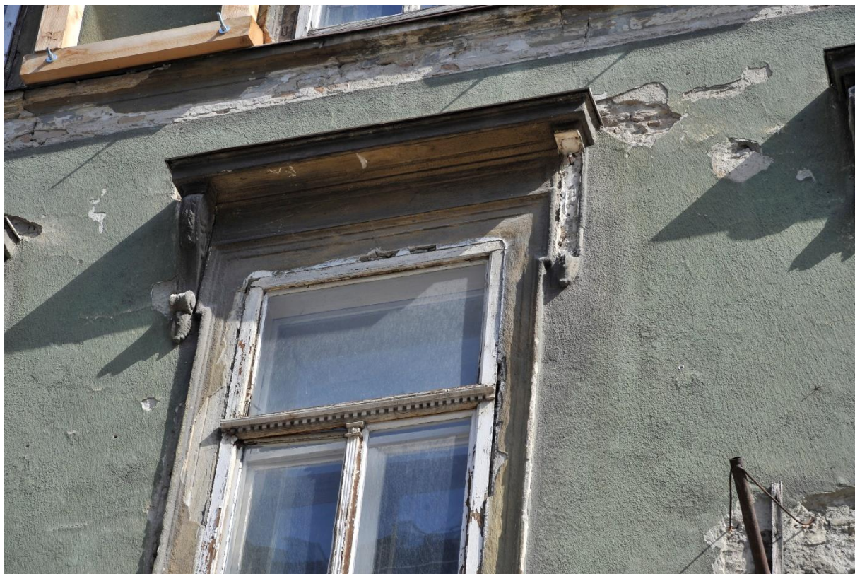
23. kép Hiányzó állókonzol az első emeleti ablak szemöldökpárkányánál
