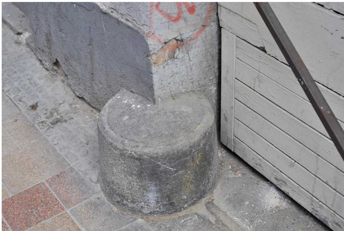
19. kép Mészke kerékvető a kapu mellett
