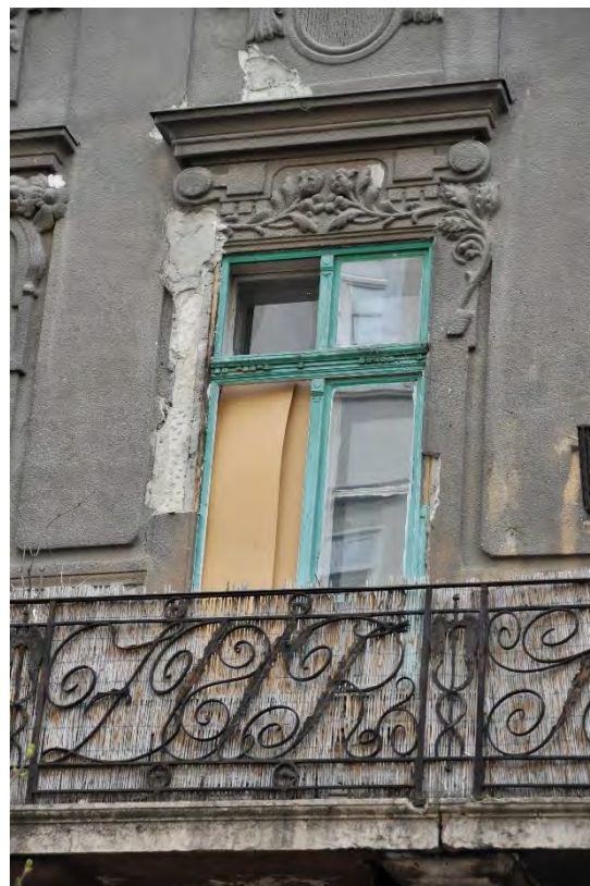
28. kép Homlokzat leromlása az 1. emeleten
