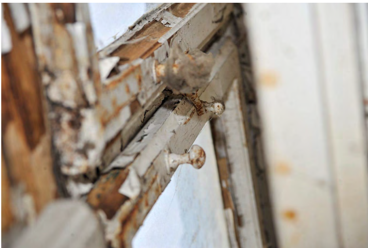
14. kép Szellőzőszárnyak a 205. sz. ablak külső rétegén
