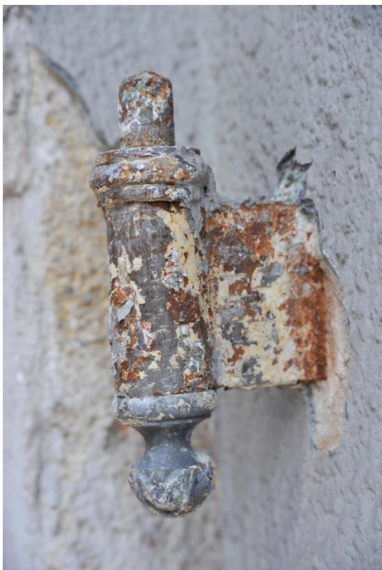
9. kép Letisztított, klasszicista zsulugáterpánt a kőkeretbe rögzítve a 002. sz. boltportálnál
