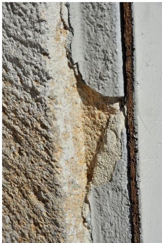
10. kép Színezésvizsgát a földszinti kőkereten
