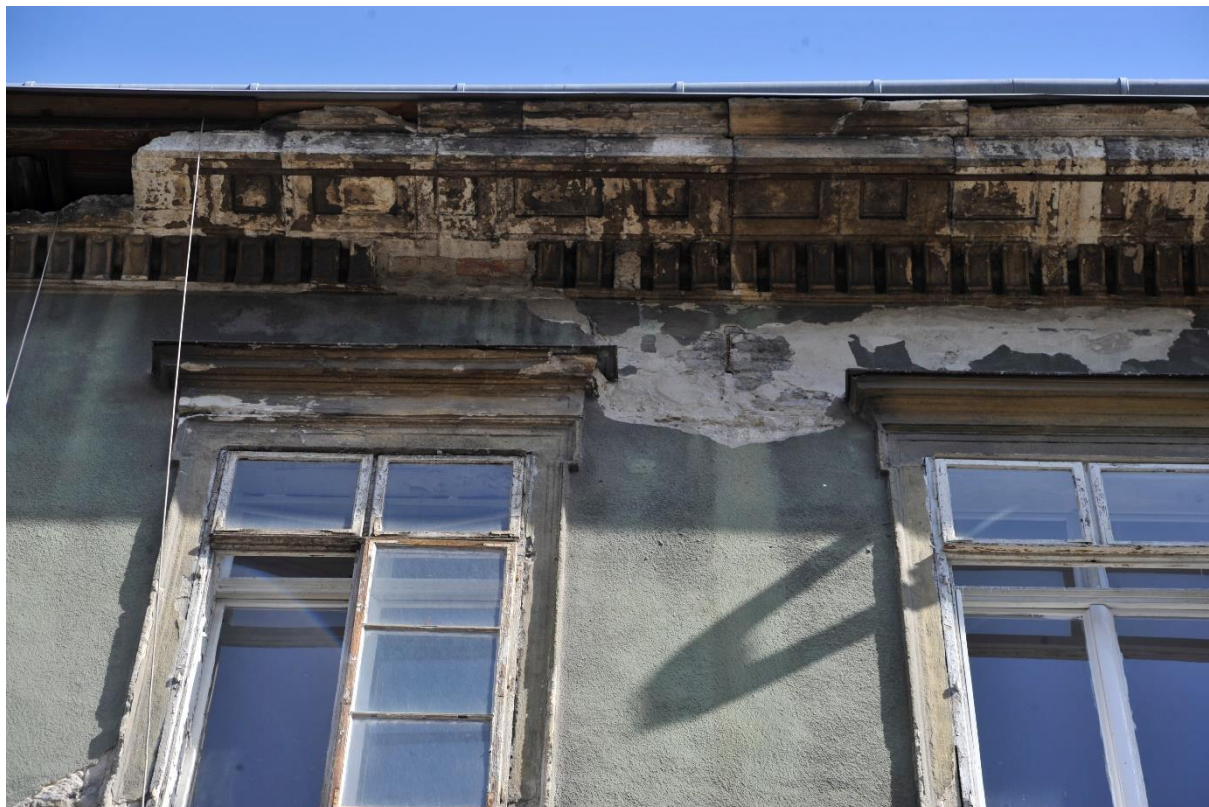
24. kép Leromlott függőlemez a zárópárkánynál
