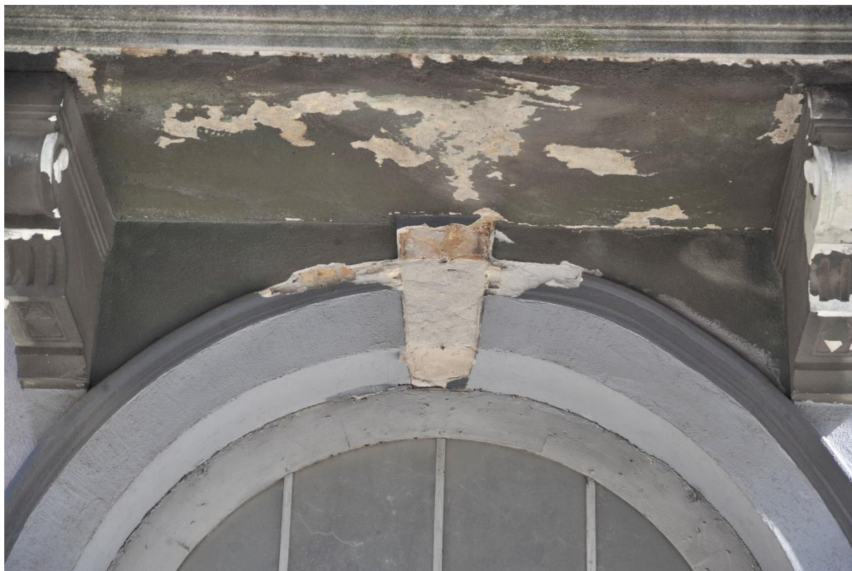
25. kép Hiányzó zárókő-motívum a kapu felett
