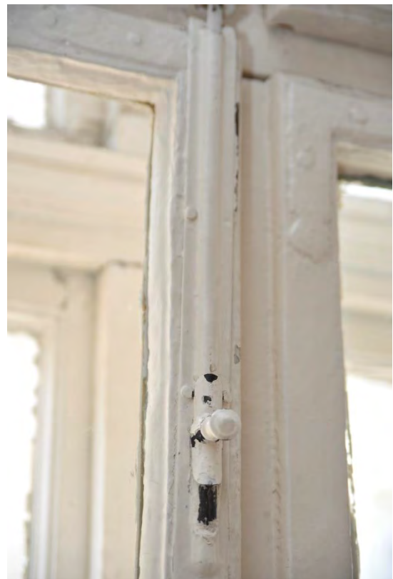
14. kép Tolózár a 101. sz. ablak belső rétegén
