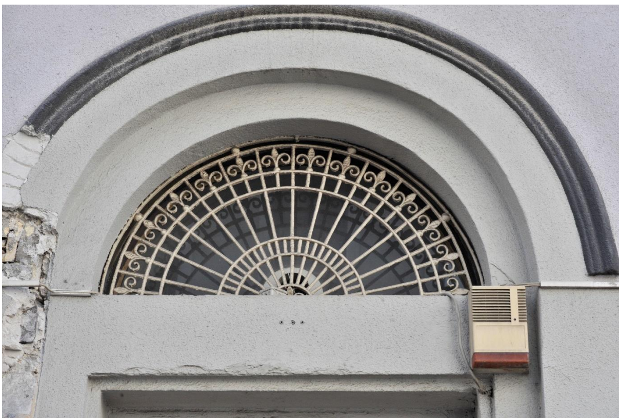
11. kép Öntöttvas rács a 001. sz. boltbejárat feletti lunettában
