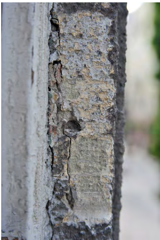
25. kép Homlokzati színezésvizsgálat, 1. emelet
