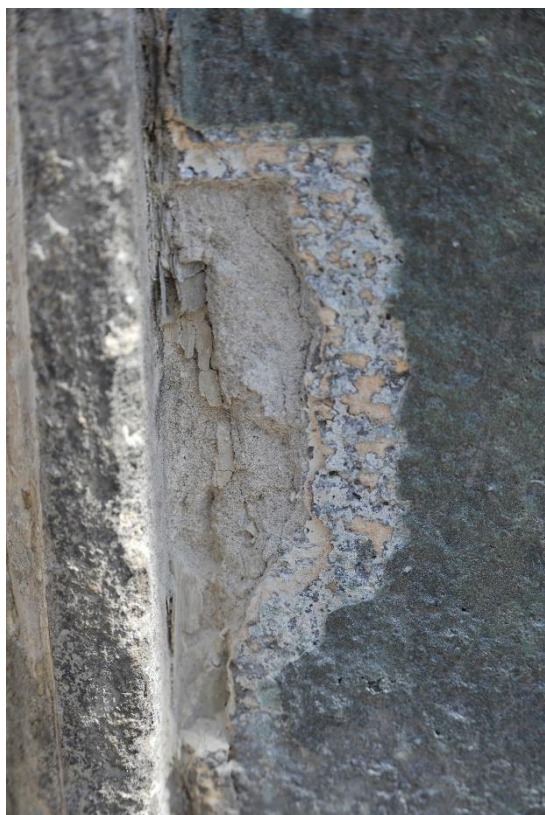
13. kép Színezésvizsgálat az első emeleti erkélyajtó mellett a vakolt felületen
