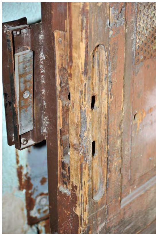
22. kép Zár és kilincspajzs helye a kapuszárnyban
